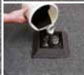
залить рамку битумно-полиуретановым герметиком.
